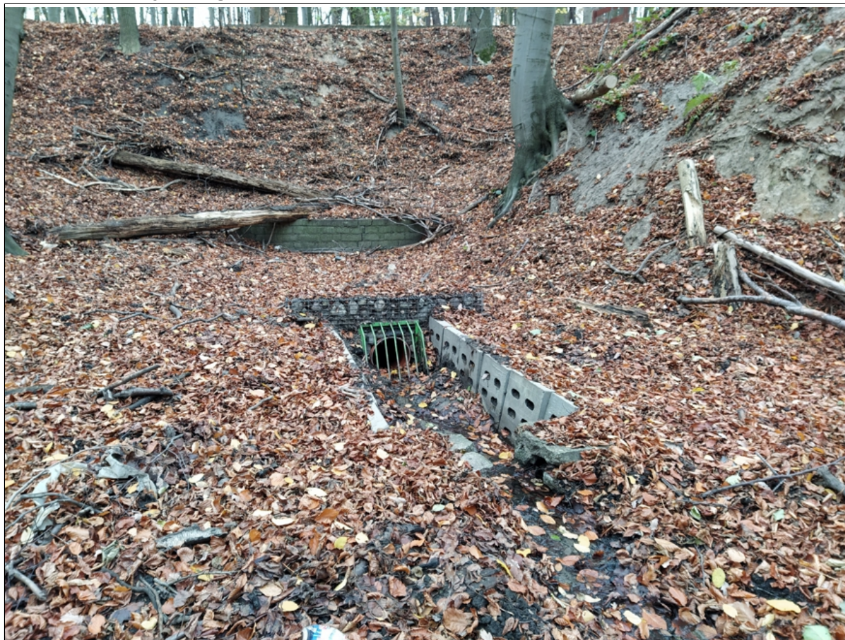
Przepust poniżej jęzora koluwialnego
