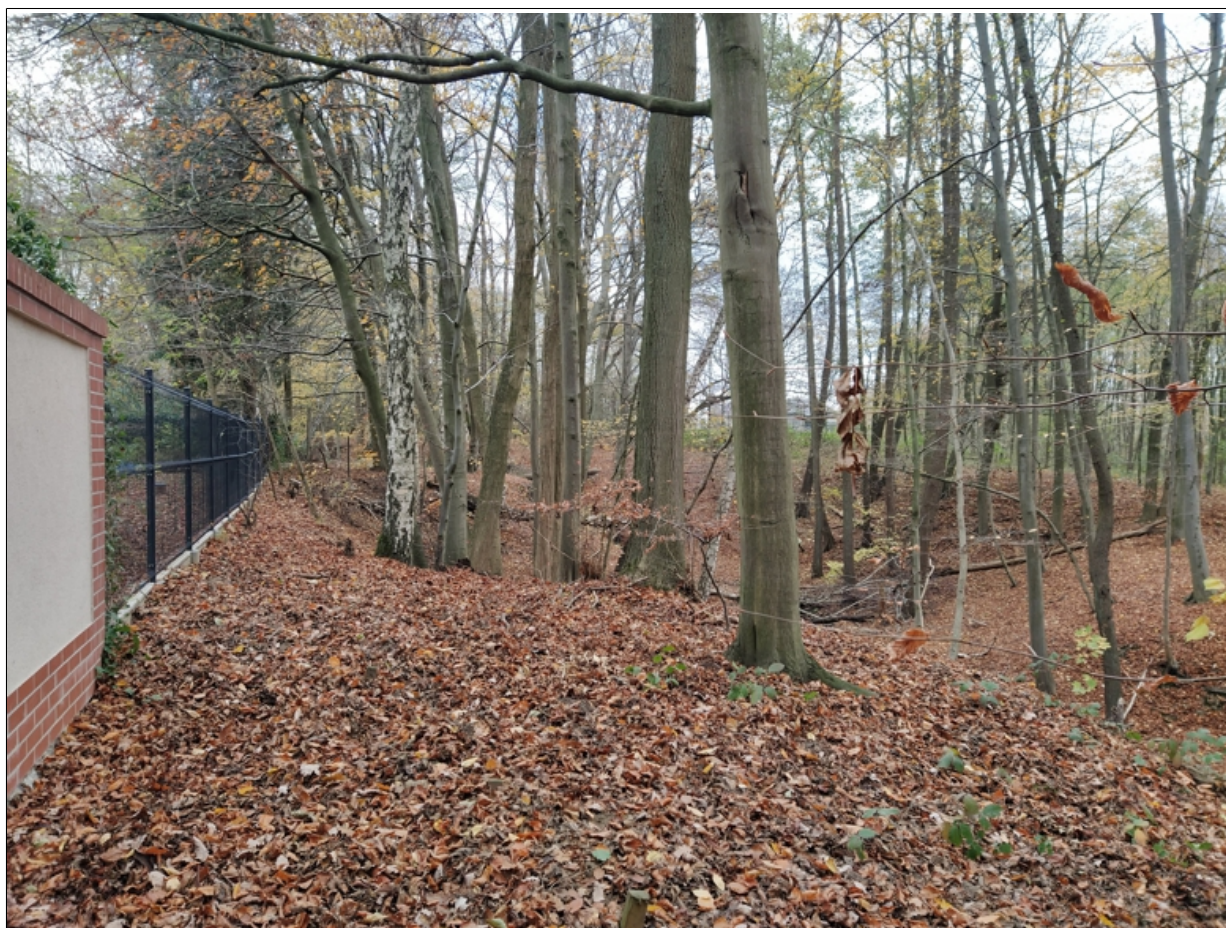
Górna krawędź osuwiska przy ogrodzeniu posesji
